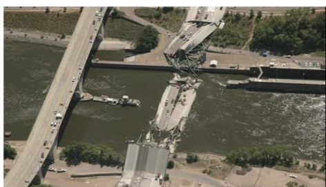
写真1 橋梁崩落事故の状況
