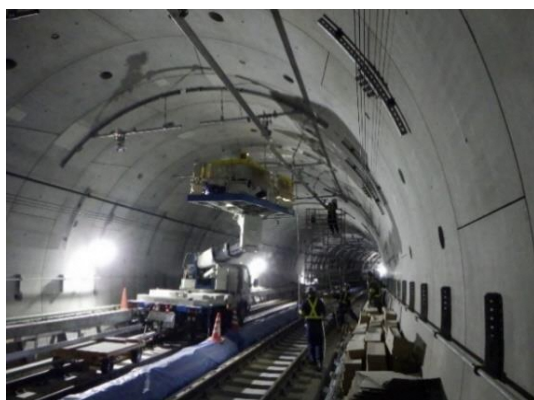
▲新横浜トンネル
