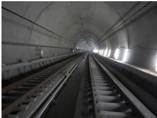
▲羽沢トンネル
