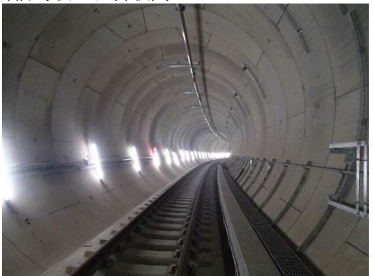
▲綱島トンネル
