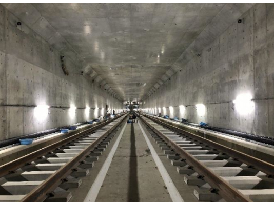
▲綱島トンネル
