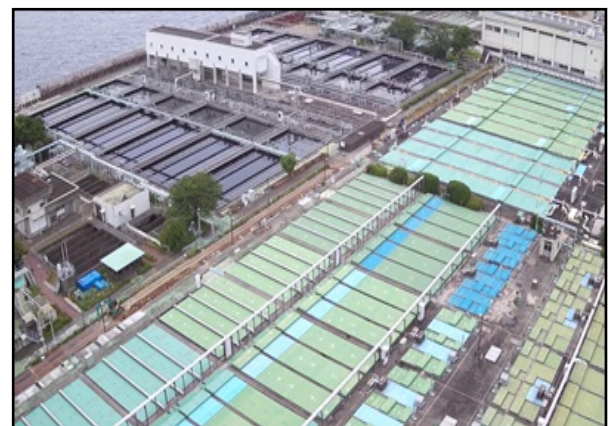
ドローンによる点検画像
