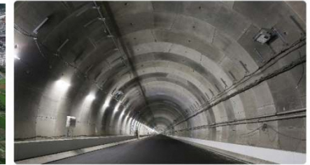
2 トンネル部 (舗装工等を実施中)
