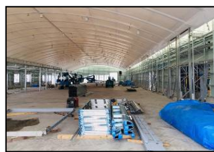
ターミナル工事の様子（12 月）
