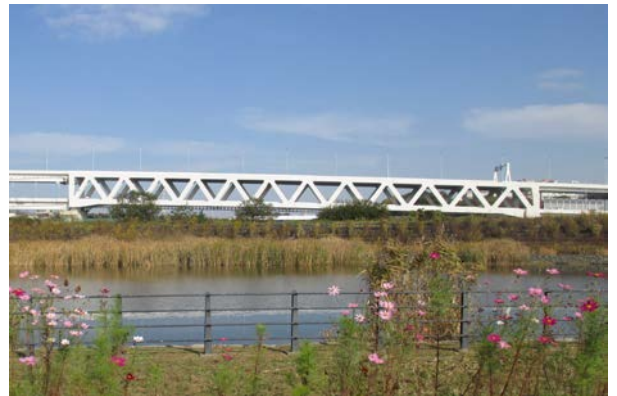
▲新横浜公園から見た大熊川トラス橋 (港北区)
